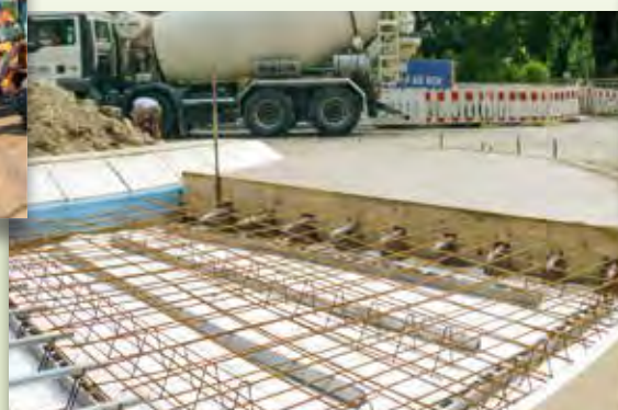
Betonage am Innenradius des neuen Kreisverkehrs am Harvestehuder Weg – Krugkoppel.
