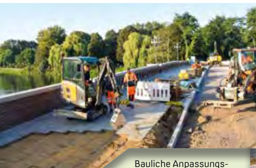
Bauliche Anpassungsarbeiten auf der Krugkoppelbrücke.
