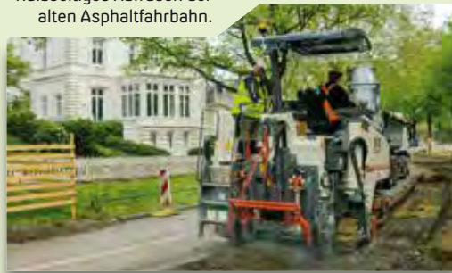
Halbseitiges Abfräsen der alten Asphaltfahrbahn.
