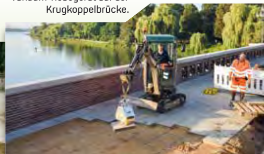
Plattenaufnahme mittels Vakuum-Hebegerät auf der Krugkoppelbrücke.
