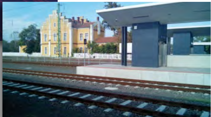
Inselbahnsteig zwischen zwei Gleisen in Törökszentmiklós.
