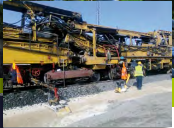
Eine Bettungsreinigungsmaschine befreit das Gleisbett von Verunreinigungen.
